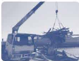
大量の流木は クレーンで降ろし ました
