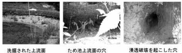
洗掘された上流面 ため池上流面の穴 浸透破壊を起こした穴
