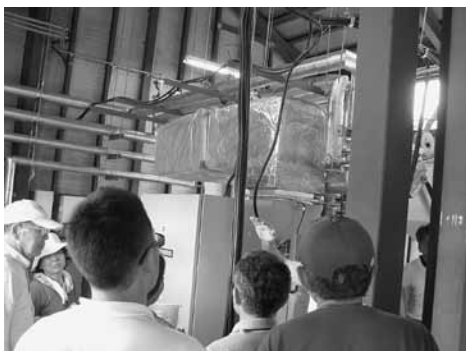
ペレットボイラー
