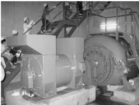
梶並発電所 最大出力 180kW
