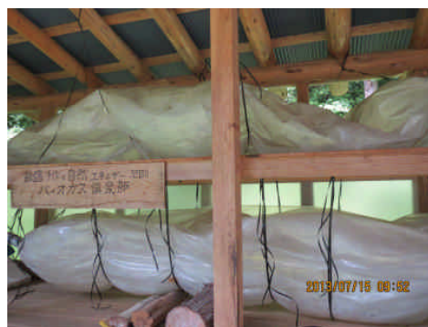
バイオガス発生装置
