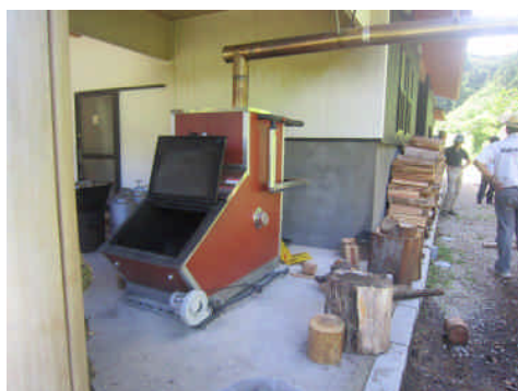
すげの里で利用されている薪ボイラー
